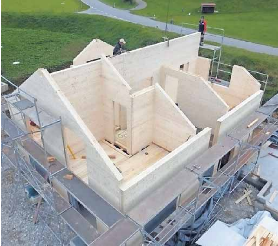
Bauen nach Zahlen: Die im Werk vorgefertigten Holzwände, hier das System von Erwin Thoma, werden zu einem Haus zusammengefügt.
